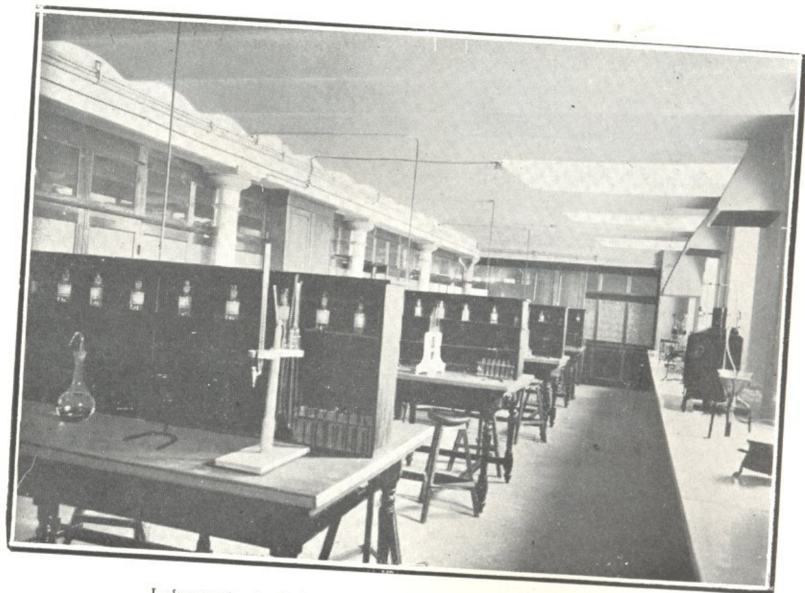
Laboratorio de Química Ampliada. (Instituto de Química)
