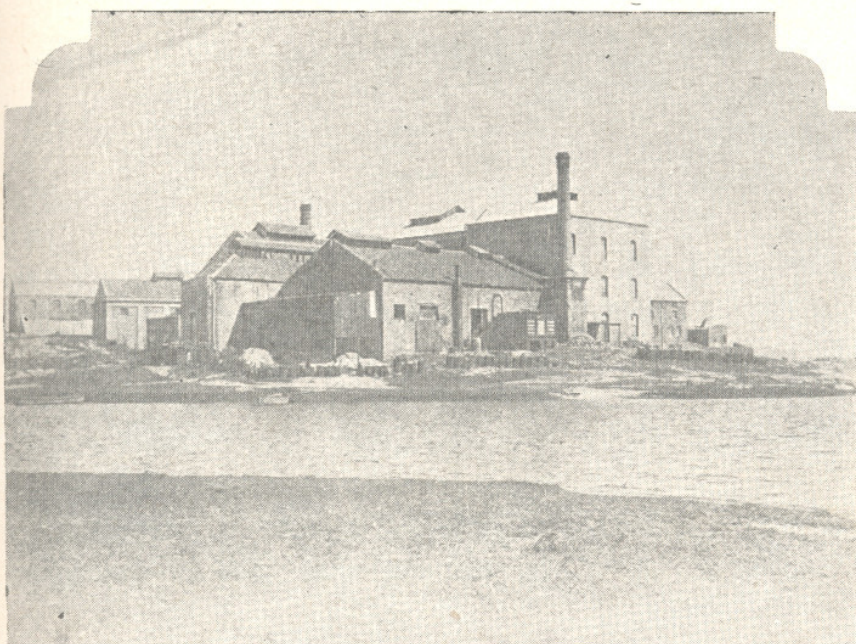
Vista general de la Fábrica de Ácido Sulfúrico
