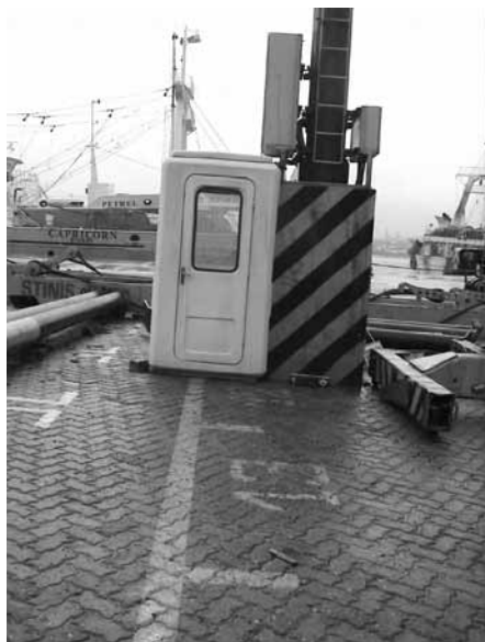
Figura A. Cabina en el puerto de Montevideo (24/05/04).
